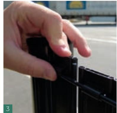
3 Positionner les lattes dans le panneau puis ajouter les clips plastiques sur la partie haute des lattes.
