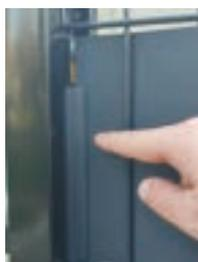
Pour un montage avec le poteau AXYLE®, le clip plastique doit être utilisé. Clipsez-le sur le dernier fil vertical de votre panneau.
