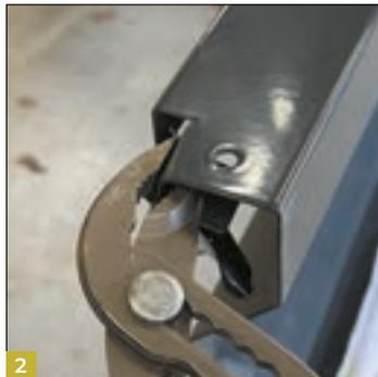
2 Avec une pince, prenez la languette et faites une rotation afin de tordre la languette. À réaliser avant montage de la plaque entre les poteaux.
