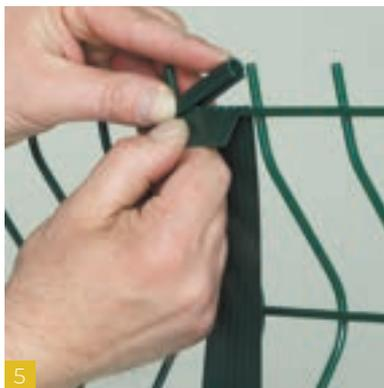
Pliez la lamelle et verrouillez la avec un clip. Répétez l'opération.
